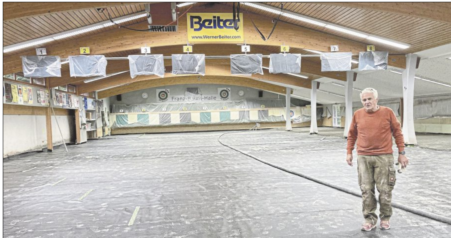
Manfred Baum in der Bogenhalle, die bei der Flut Anfang Juni Schaden nahm.
