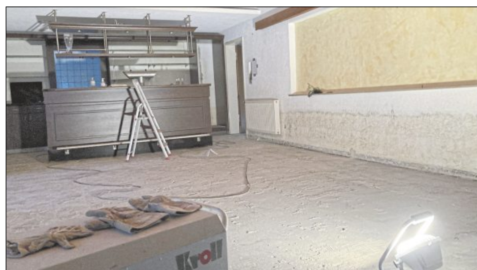
Noch ist das Schützenhaus, hier der Gasträum mit Theke, eine Baustelle.
